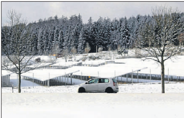
Eingeschnit: Die Module des Solarparks Laisa wurden Ende vergangener Woche komplett mit Schnee bedeckt.
